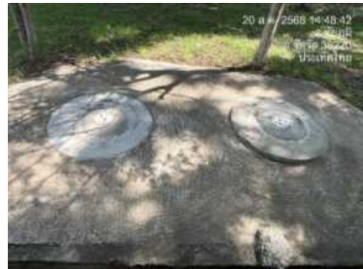
รูปที่ 33 ระบบบ่อเกราะ-บ่อซึม สำหรับบำบัดน้ำเสียจากห้องส้วม
