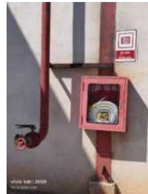
รูปที่ 61 ระบบท่อเย็น และหัวจ่ายน้ำดับเพลิง
