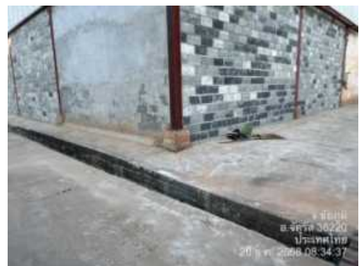
รูปที่ 67 รางระบายน้ำรอบอาคารเก็บสารเคมี
