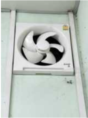
รูปที่ 68 ระบบระบายอากาศภายในอาคารเก็บสารเคมี
