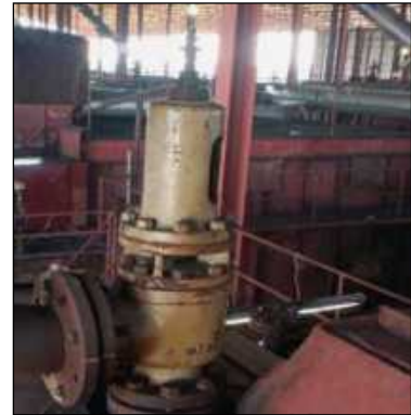
รูปที่ 90 อะไหล่ลิ้นบริกของหม้อไอน้ำและกังหันไอน้ำ
