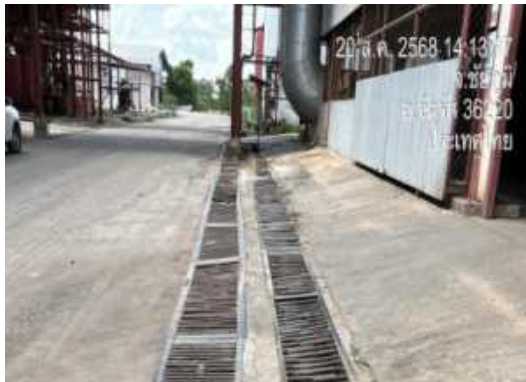
รูปที่ 26 รางระบายน้ำฝนแยกกับจากรางระบายน้ำเสีย
