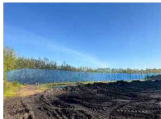
รูปที่ 15 การติดตั้งโครงเหล็กติดตั้งตาข่ายรอบลานกองเถ้า
