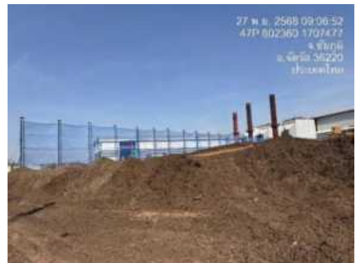
รูปที่ 56 การติดตั้งโครงเหล็กติดตามขี้เถ้ารอบลานกองเก็บขี้เถ้า
